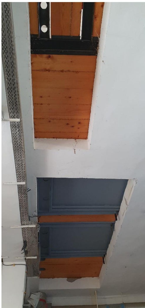
Födémáttörések az átalakítandó helységben
