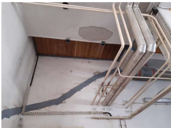
Födémáttörés az átalakítandó helyiségben, egykori lépcső nyomai
